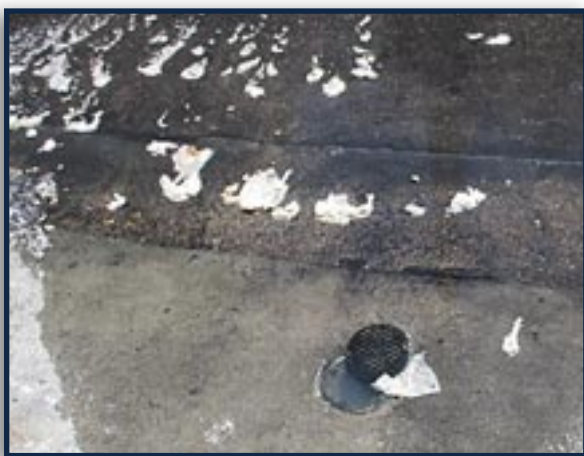
Fig. 2: Aguas residuales sin tratar, trozos de papel higiénico y otros sólidos que se derraman de una boca de limpieza. Las aguas residuales sin tratar y los sólidos que salen a la superficie contaminan carreteras, calles y el lago Mead.
